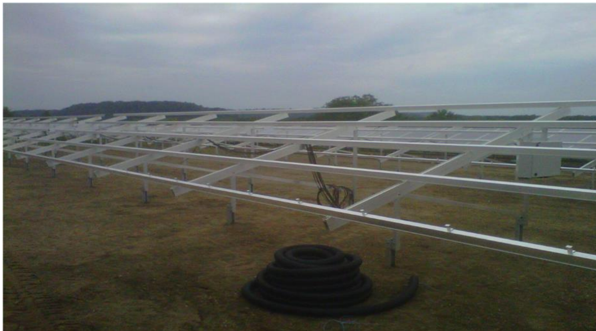
Zdj. 2. Poglądowe zdjęcie obrazujące konstrukcję nośną
