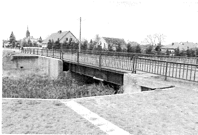
Zdjęcie nr 28. Most przechylny-przesuwny K804 na rzece Obrze w zespole Międzyrzeckiego Rejonu Umocnionego w Bledzewie
