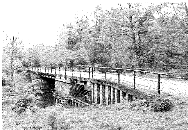
Zdjęcie nr 29. Most zwodzony – obrotowy D812 na Kanale Taktycznym 813 w Zespole Międzyrzeckiego Rejonu Umocnionego w Starym Dworku
