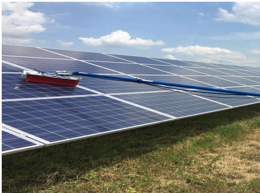
Fot. Mycie paneli fotowoltaicznych
