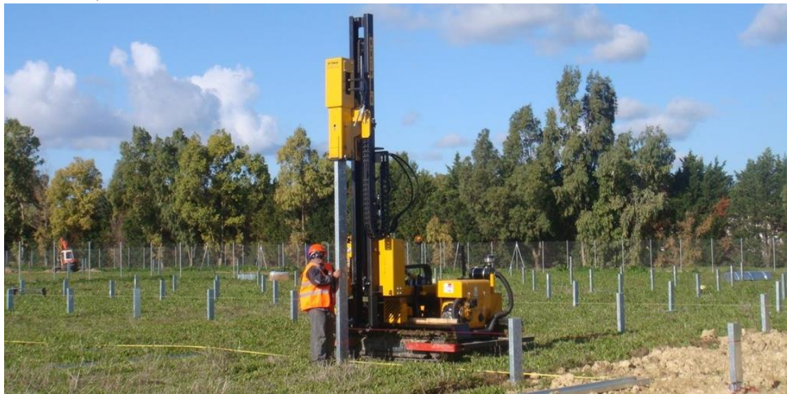
Zdjęcie- Budowa podpór pod panele
