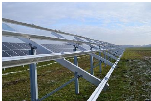
Pic. 8. Sposób montażu konstrukcji fotowoltaicznych
