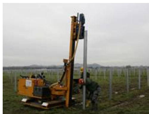
Pic. 8. Sposób montażu konstrukcji fotowoltaicznych
