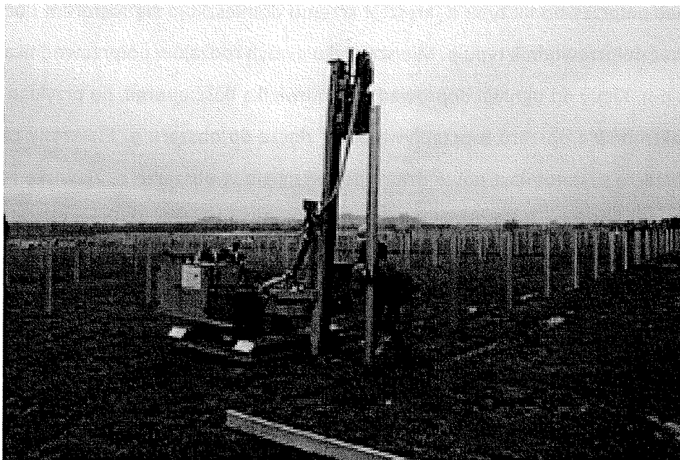
Zdjęcie 2. Montaż profili za pomocą kafara.
