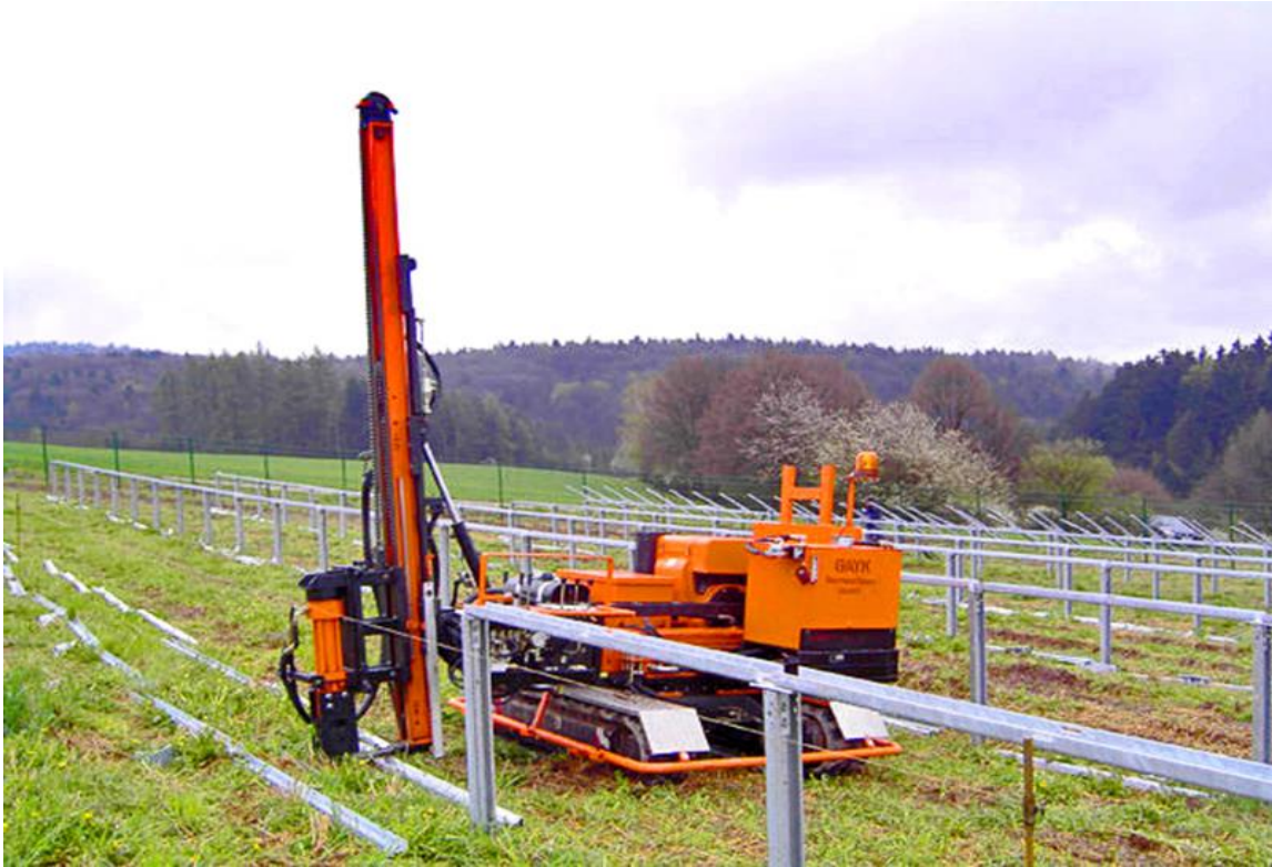
Fot. 2. Maszyna wciskająca konstrukcje stalowe w grunt. Zdjęcie www.projekt-solartechnik.pl .
