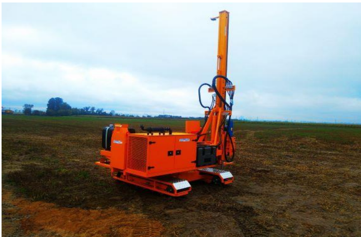
Rycina 4. Budowa konstrukcji za pomocą kafara.
