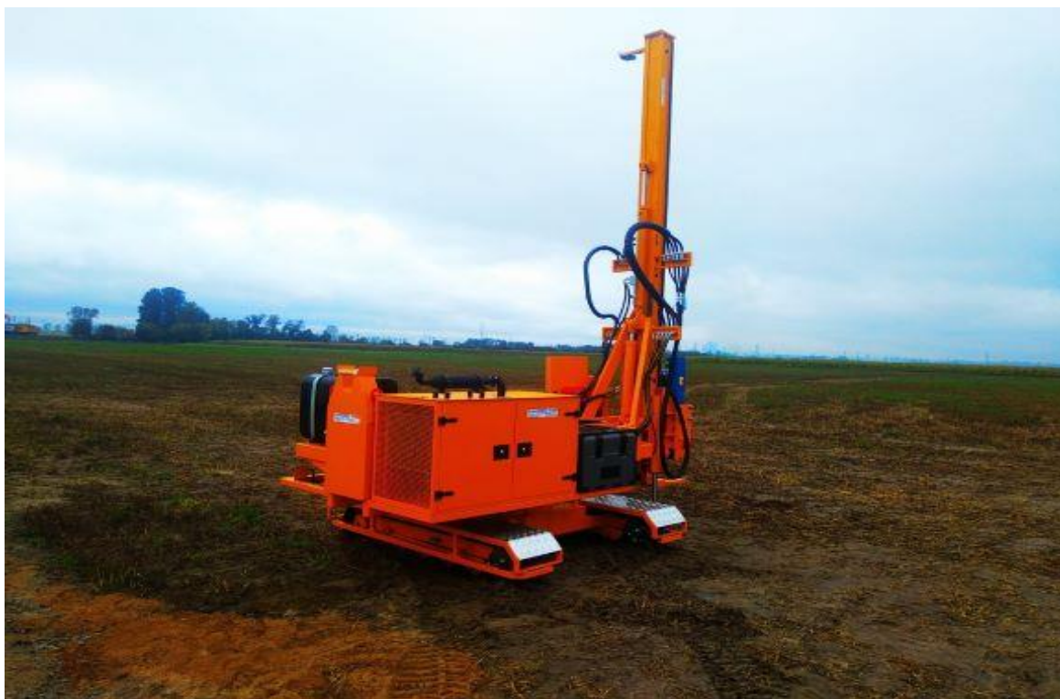
Rycina 4. Budowa konstrukcji za pomocą kafara.
