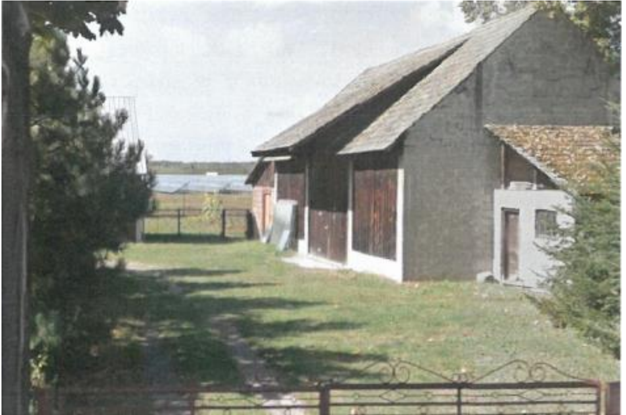
Rycina 17. Widok na instalację fotowoltaiczną z odległości ok. 140 m.
