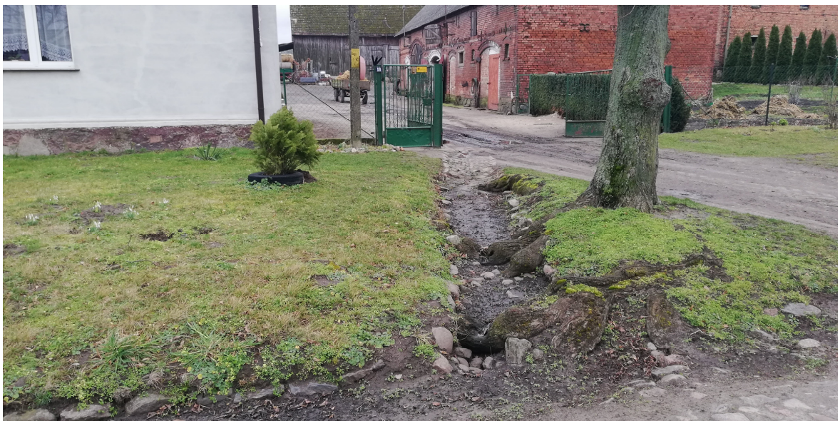
Przykład istniejącego wpustu wymagającego przebudowy
