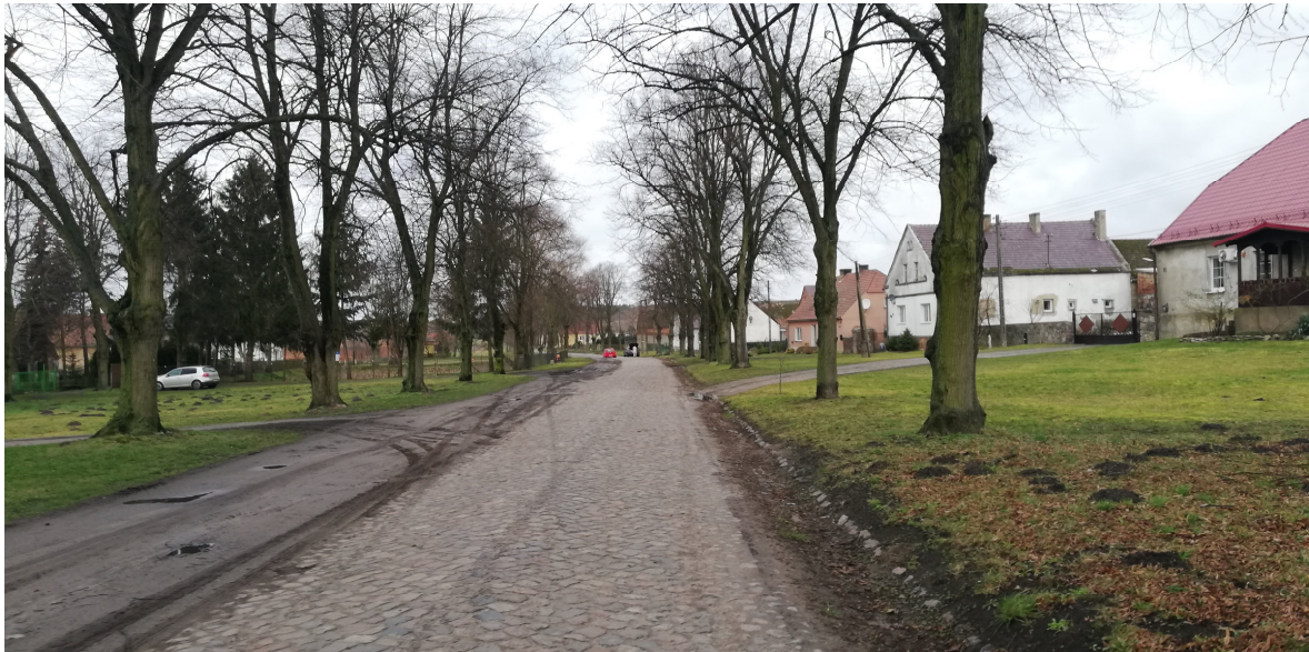
Istniejąca droga o nawierzchni z brukowca z widocznym rynsztokiem po prawej stronie
