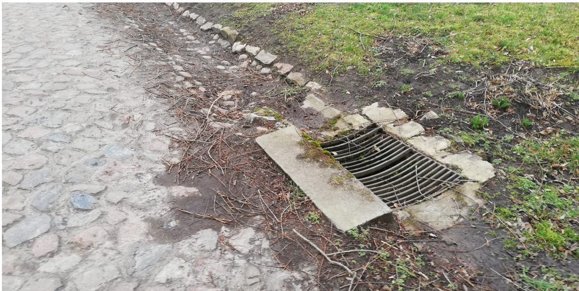
Przykład istniejącego wpustu wymagającego przebudowy
