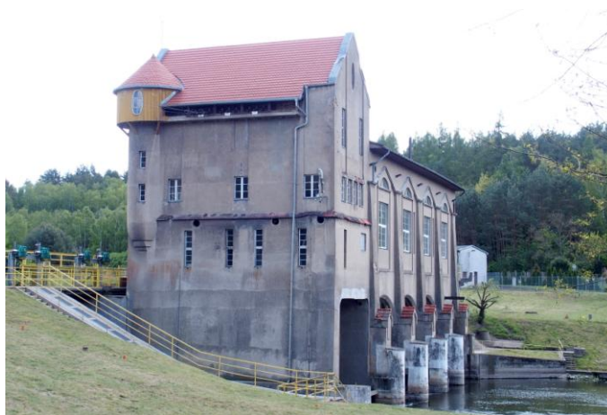
Zdjęcie nr 27. Elektrownia wodna w Bledzewie
