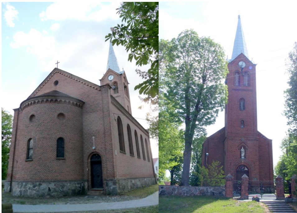
Zdjęcia nr 12, 13. Kościół ewangelicki, ob. parafialny rzymskokatolicki pw. Wniebowzięcia NMP w Sokolej Dąbrowie
