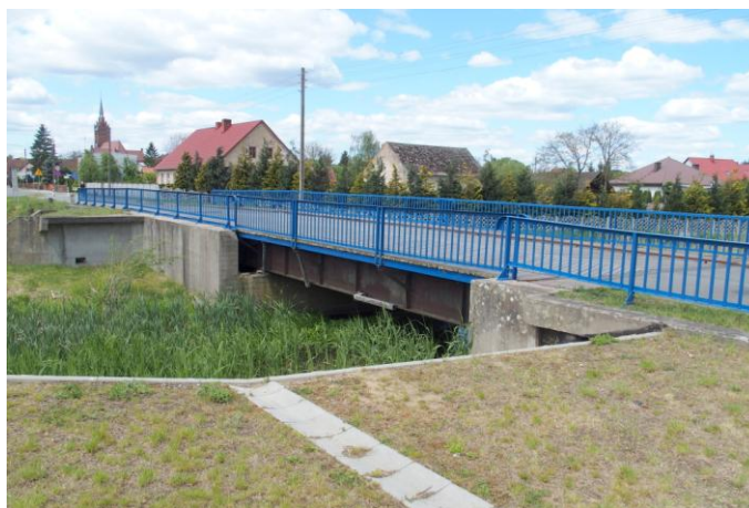
Zdjęcie nr 28. Most przechylno - przesuwny K804 na rzece Obrze w zespole Międzyrzeckiego Rejonu Umocnionego w Bledzewie
