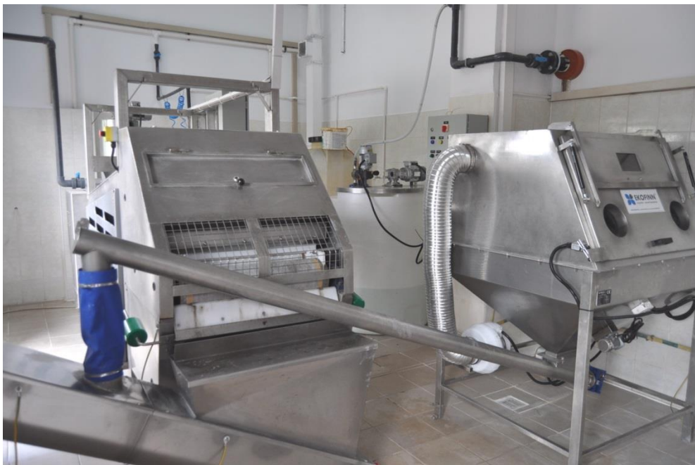
Modernizacja oczyszczalni ścieków
