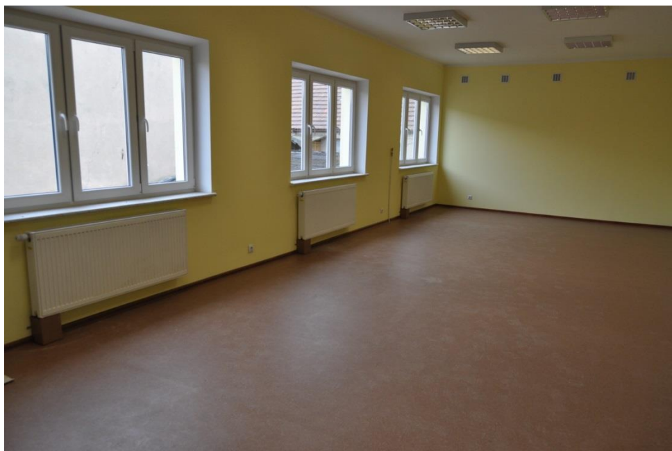
Wymiana stolarki okiennej
