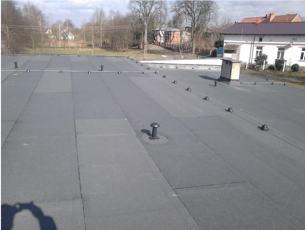
Ocieplenie stropodachu sali wiejskiej w Goruńsku
