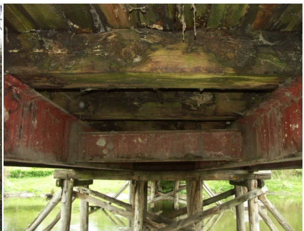
Ustrój nośny i pomost – widok od spodu
