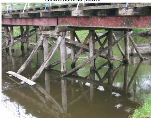
Widok na podpory nurtowe
