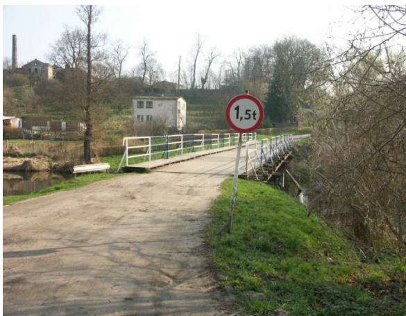
Widok ogólny mostu
