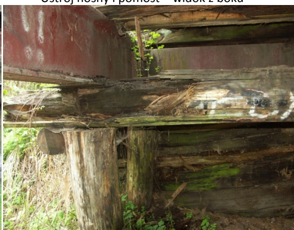
Widok na podporę skrajną
